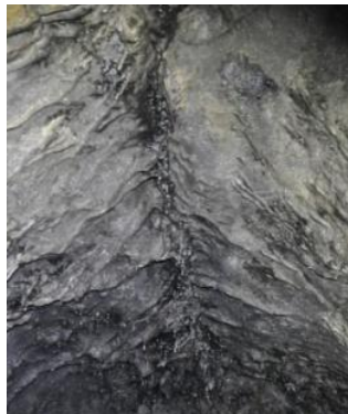
Slika 6.2.1.12.: Pukotina sa sigama na stropu
