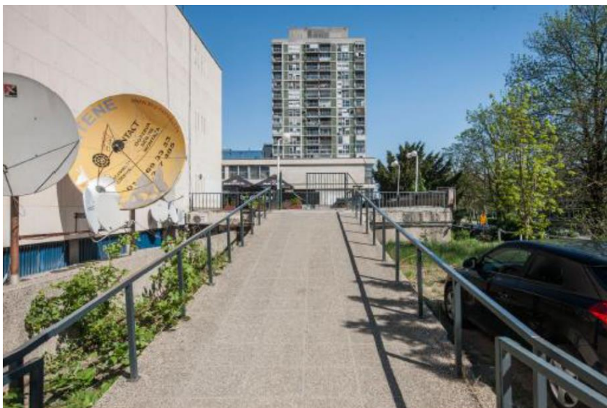
Slika 41. Zgrada Radničkog sveučilišta "Moše Pijade", Ulica grada Vukovara 68, zapadni prilaz na vanjsku terasu 278
