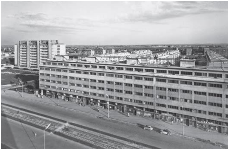
Slika 46. Pročelje uredske zgrade Nevena Šegvića, Ulica grada Vukovara 56-60 288
