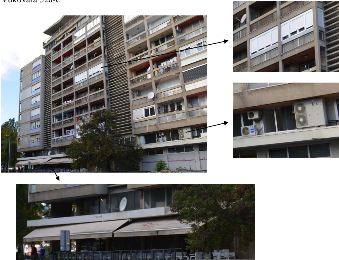
Slika 57. Detalj začelja višestambene osmerokatnice Vojne Mornarice Stanka Fabrisa, Ulica grada Vukovara 52a-e 303
