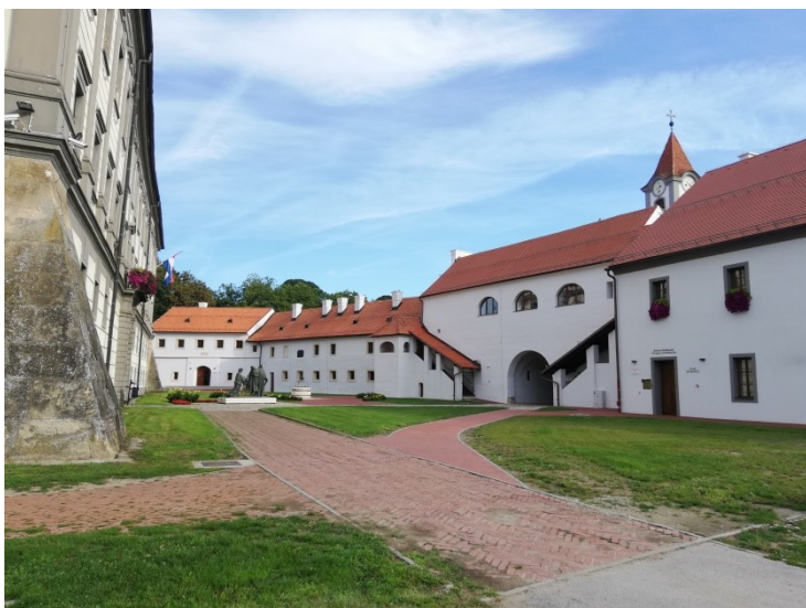
Slika 17: Zgrade s dvorišne strane bastiona, pogled s istoka
