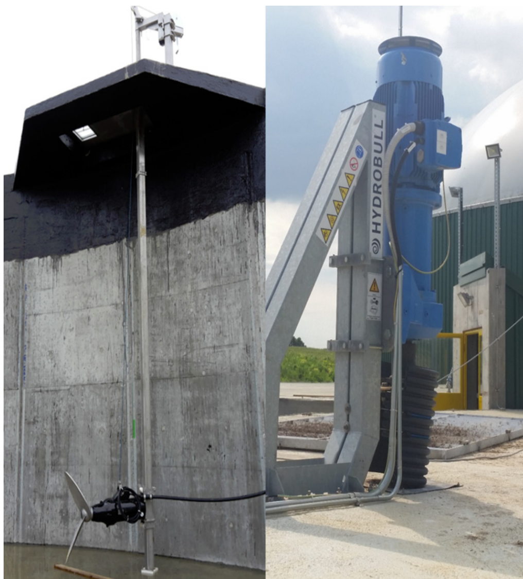
Slika 13 Propelersko miješalo i elektromotor za pogon istog [41]
