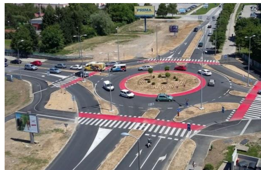
Slika 25. Vođenje biciklista izvan kružnog raskrižja
