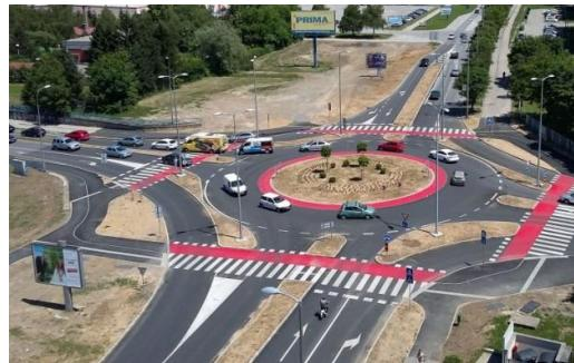
**Slika 25. Vođenje biciklista izvan kružnog raskrižja**
