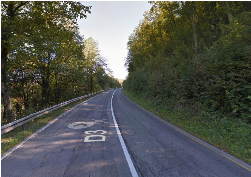
Slika 17. Postojeće stanje na dionici (14) Stubica (14) (D42) - Kupjak (Z5034), stacionaža (0,002 - 0,250), smjer Stubica
