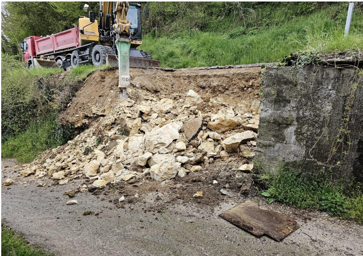
Slika 26. Sanacija ceste kod Ozlja
