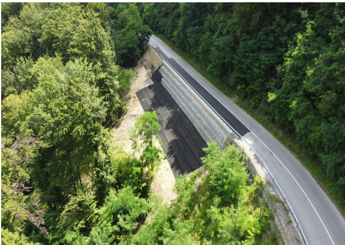
Slika 25. Sanacija klizišta na dionici Slunj - Maljevac
