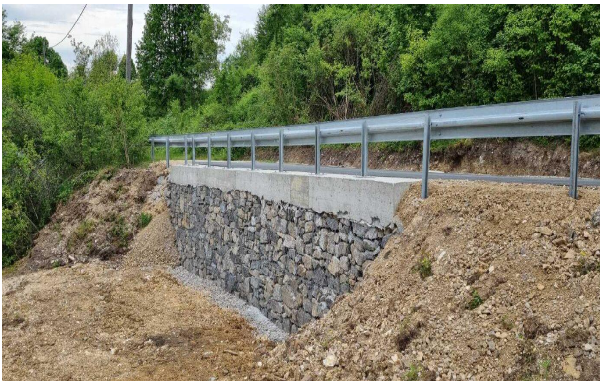
Slika 27. Sanacije ceste i padine kod Veljuna
