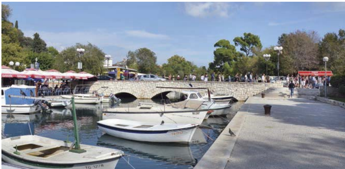
Slika 4. Kameni most između Trogira i kopna
