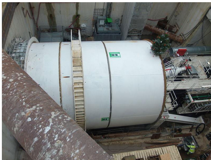
Slika 27: Izgradnja linije B (na slici prikaz uređaja za tuneliranje (engl. boring machine) u gradu Rennes
