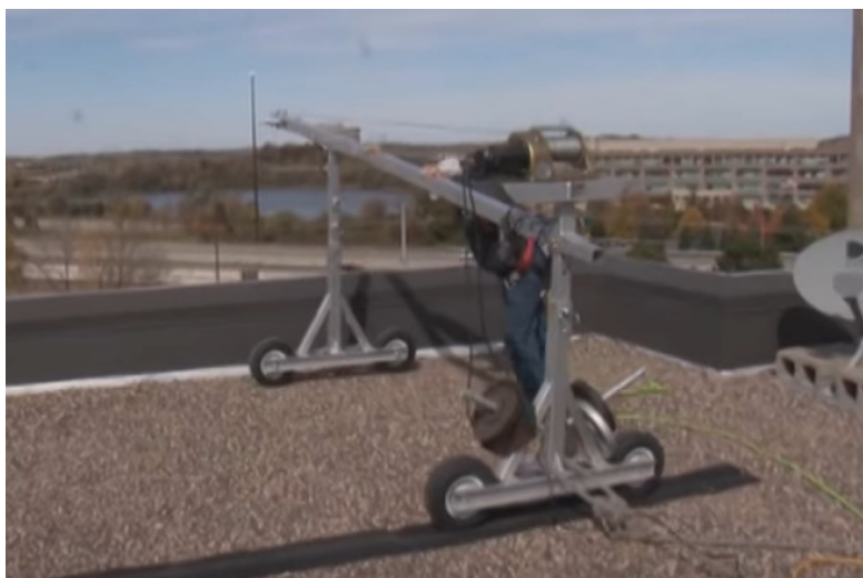
Slika 10. Uže vezano za protuoslonac
