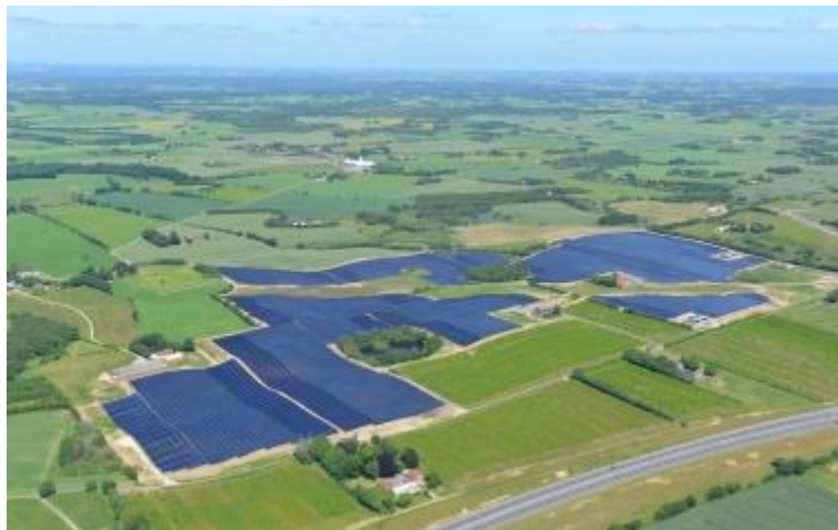
Slika 7. Solarni kolektori u Silkeborgu [9]
