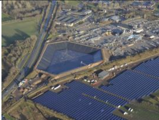
Slika 8. Solarna toplana sa spremnikom topline u Vojensu [10]
