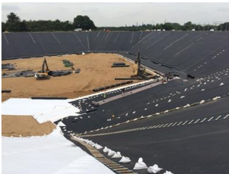
Slika 6. Izgradnja toplinskog spremnika u Vojensu (203000 m 3 ) [8]
