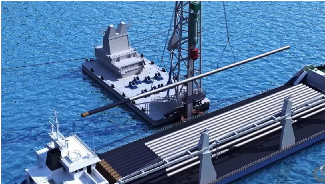
Slika 22 Specijalna dizalica koja prikazuje dizanje pilota
