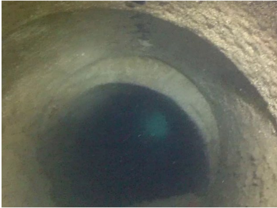
Slika 81 Fotografija slijeganja cijevnih sekcija propusta u ACI marini Opatija što može utjecati na protočnost kroz propust uslijed plime i oseke
