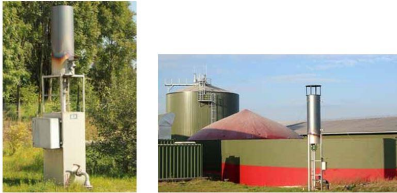
Slika 18. Plinska baklja (Bontempo i sur., 2016).
