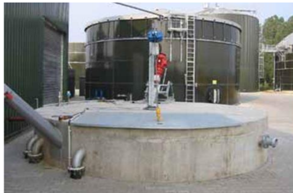
Slika 11. Pihvatni spremnik ( eng. preliminary pit ) (Bontempo i sur., 2016).
