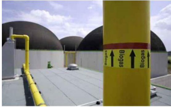
Slika 16. Plinske cijevi (Bontempo i sur., 2016).
