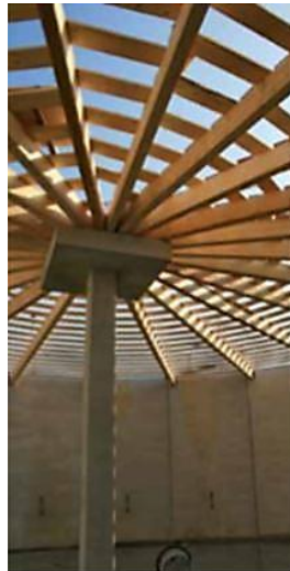
Slika 14. Drvena krovna struktura u digestoru (Bontempo i sur., 2016).
