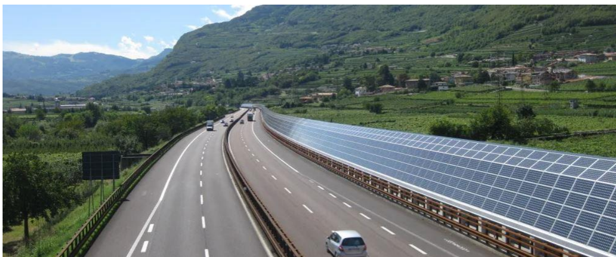
Slika 28. Primjer zvučne barijere s fotonaponskim panelima [50]
