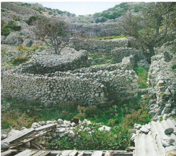
Slika 159., 160., 161., 162. Stanovi sa sklopovima suhozida (Izvor: Oštarić, I. (2017.) Stani otoka Paga: Od prapovijesti do danas, str. 430, 450, 456 i 465)
