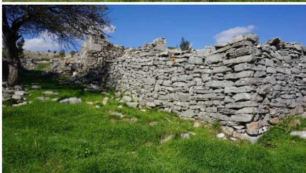
Slika 322., 323., 324., 325. Pritorak uz košaru za veću stoku sagledan sa sve četiri strane s visokim suhozidom
