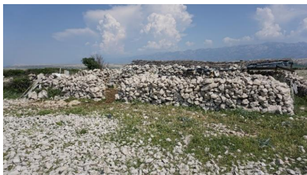
Slika 179. i 180. Struga na neograđenom pašnjaku na području Poveljane. Ispred natkrivenog dijela nalazi se suhozidom ograđen predprostor pregrađen po sredini s ulaznim otvorom
