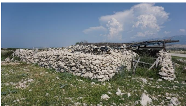
Slika 179. i 180. Struga na neograđenom pašnjaku na području Poveljane. Ispred natkrivenog dijela nalazi se suhozidom ograđen predprostor pregrađen po sredini s ulaznim otvorom
