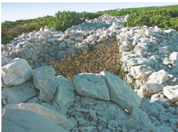
Slika 156. i 157. Nastamba širokih zidova i nastamba na kojoj su zidovi okrenuti prema buri debljine i do 1.5 metra (Izvor: Oštarić, I. (2017.) Stani otoka Paga: Od prapovijesti do danas, str. 388 i 444)
