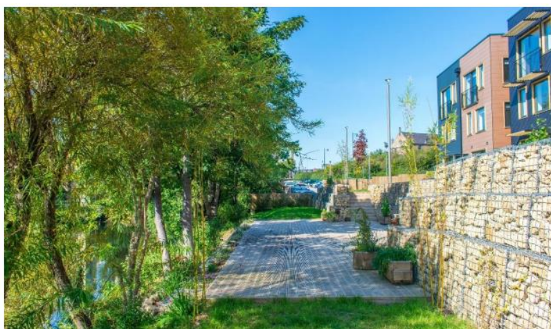
Slika 4.4.5. Prikaz propusnog opločenja. Climate Innovation District. Izvor: 009_01_06_20_climate_innovation_leeds_2020_awards.pdf - pristup 27.6.2022.
