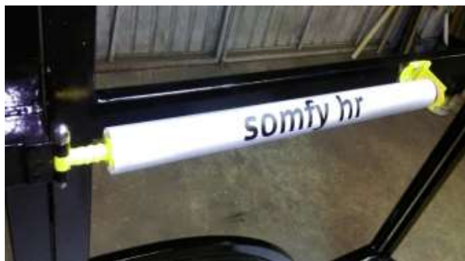
Slika 61. Prikaz montaže cijevnog elektromotora na vrata traktora
