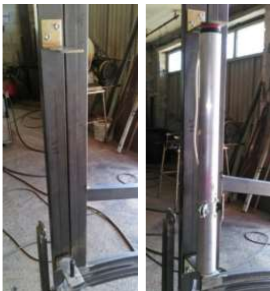
Slika 49. Držači cijevi cijevnog elektromotora
