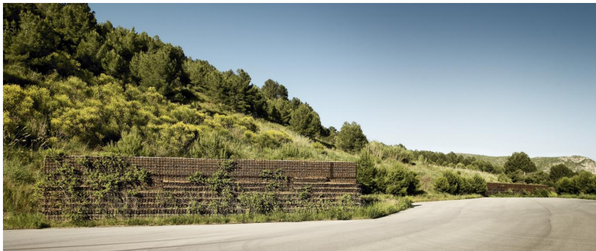
Slika 52: Prikaz trenutne situacije – gabioni
