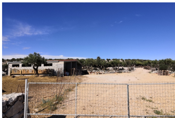
Slika 53. Novopodignuta gospodarska građevina
