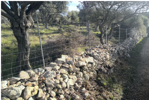
Slika 43. i 44. Obnovljeni suhozid ojačan žičanom ogradom i mladi cijep pitome masline na divljoj podlozi ( Olea oleaster )
