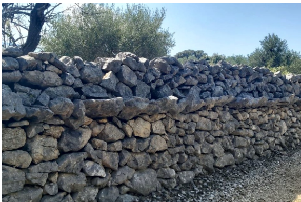
Slika 6. Ozub – naziv za ravne, koso položene kamene ploče koje služe učinkovitijem sprječavanju preskakanja ovaca
