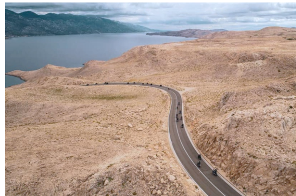
Slika 173. Asfaltirana prometnica prema trajektnom pristaništu privlači mnogo pažnje
