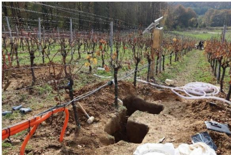
Slika 3.2.1. Iskop jame za postavljanje tlačnih lizimetara
