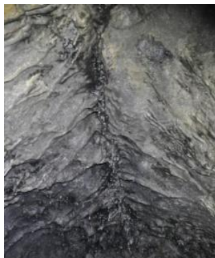
Slika 6.2.1.12.: Pukotina sa sigama na stropu
