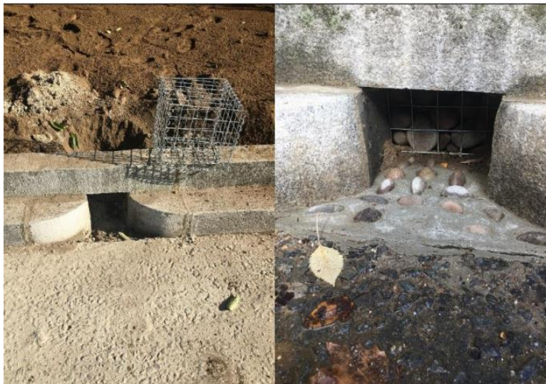
Slika 4.6.3. Gabion za otjecanje vode.
