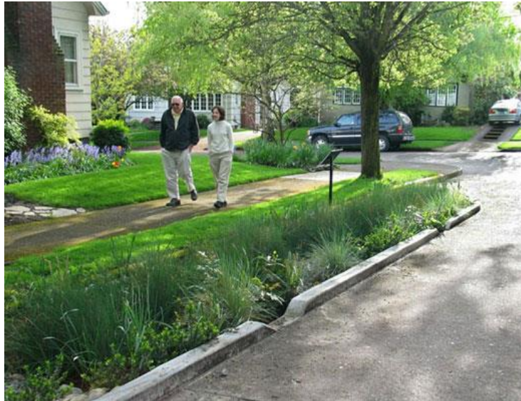
Slika 3.3.7. Bioretencija.
