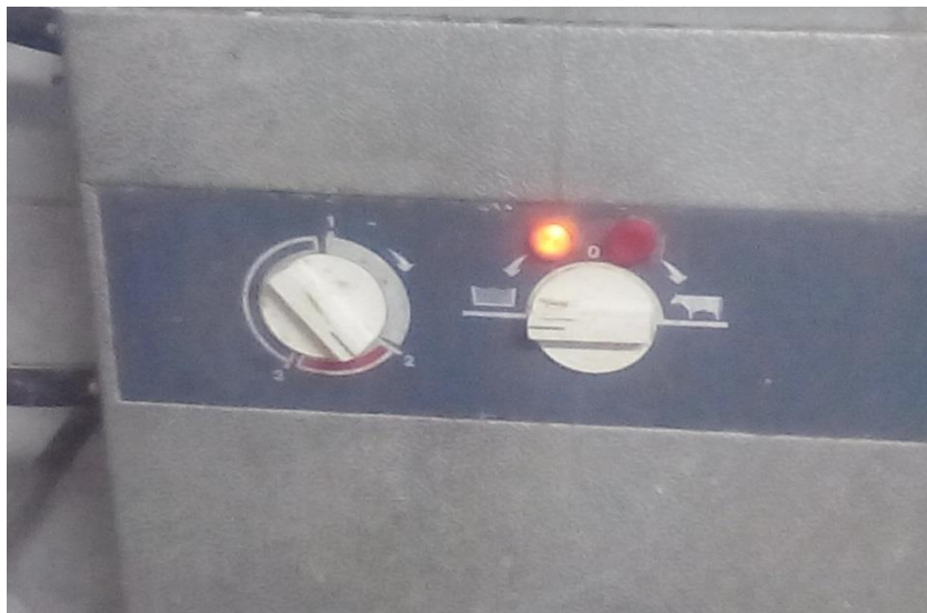
Slika 22. 1. faza, pranje hladnom vodom (Foto: Švub)
