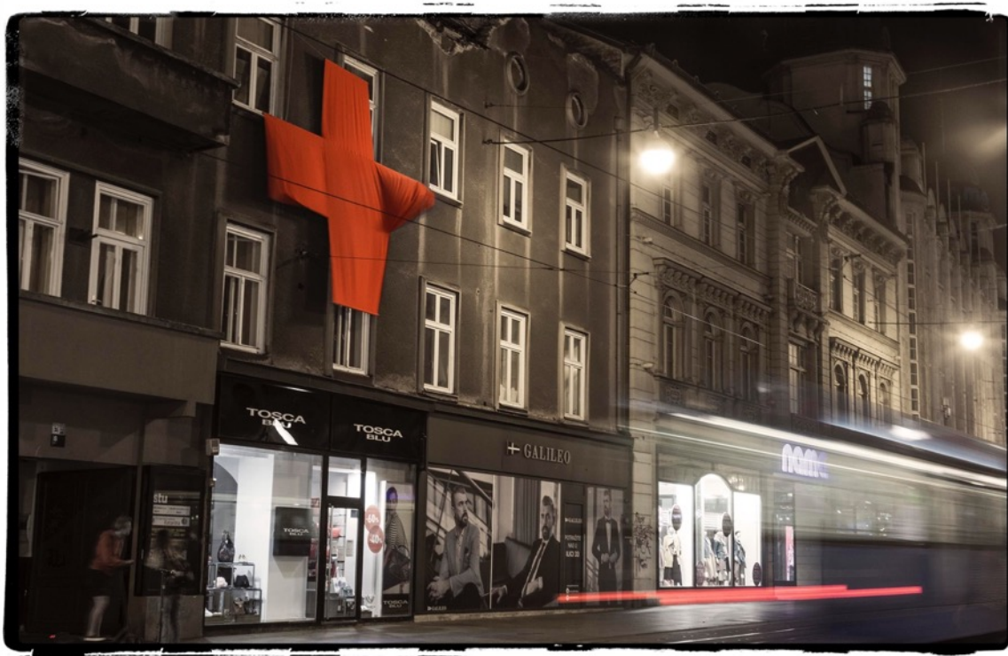
slika 27. Crveni križevi na oštećenim zgradama u potresu, Ilica 8, Zagreb, 2020. (foto Jasmin Krpan)
