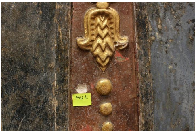
Sl. 95 - Područje uzetih uzoraka za analizu stratigrafije
