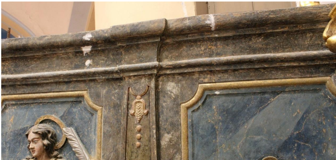
Sl. 118 - Gornji vijenac nakon izvedenih nadoknada u sloju nosioca
