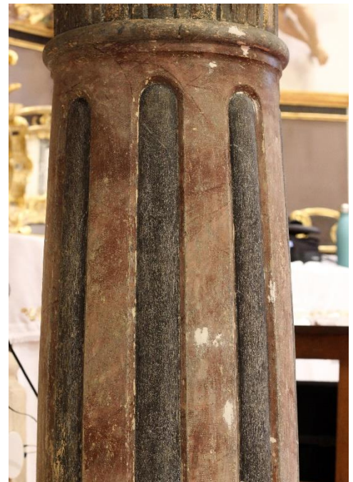
Sl. 124 - Stup, u tijeku reintegracije u slikanom sloju
