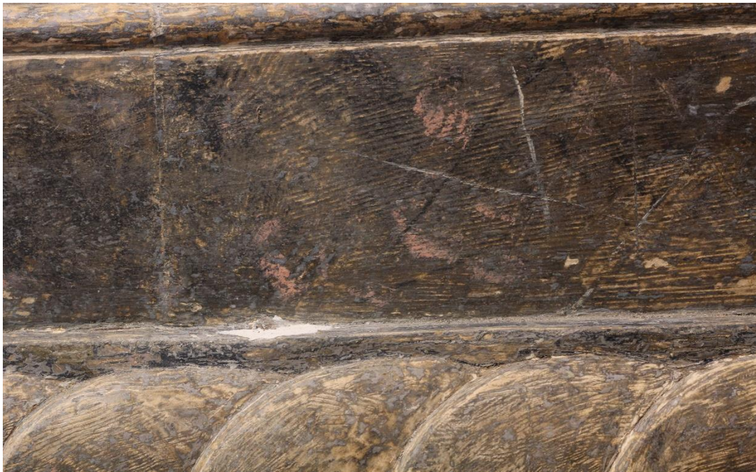
Sl. 43 - Ogrubljena površina nosioca
