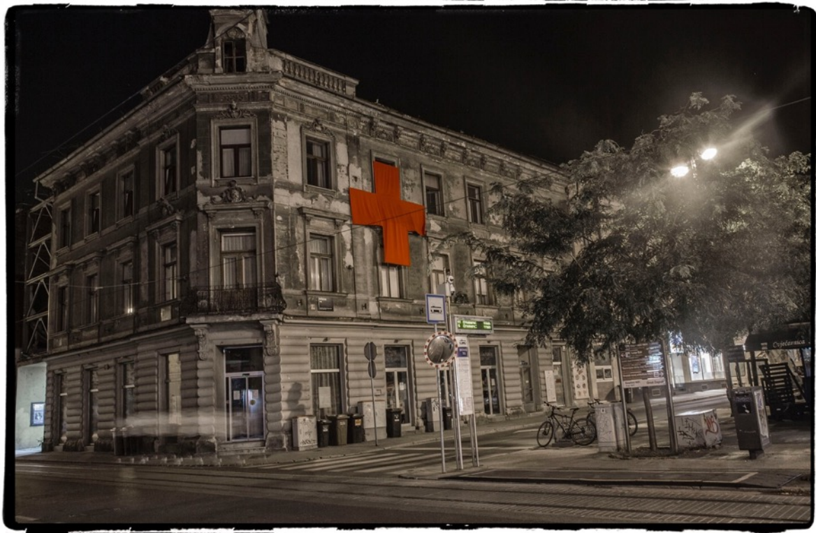
slika 24. Crveni križevi na zgradama oštećenima u potresu, Britanski trg 1, Zagreb, 2020. (foto Jasmin Krpan)
