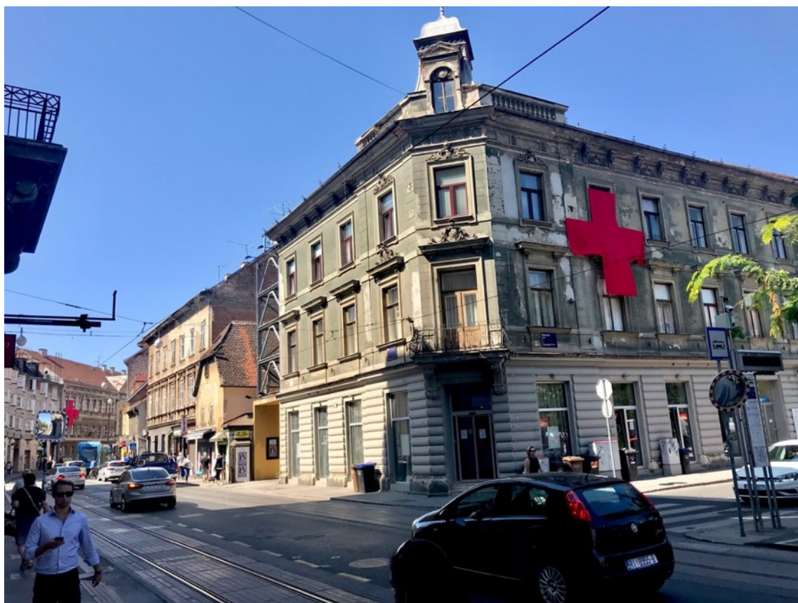
slika 22. Crveni križevi na zgradama oštećenima u potresu, Britanski trg 1, Zagreb, 2020.
