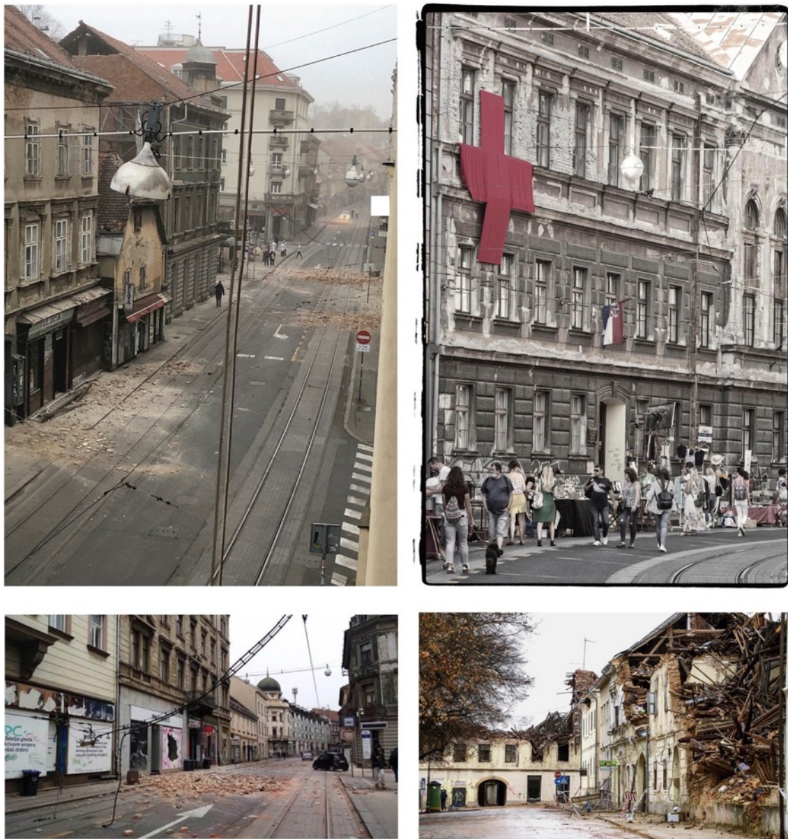
slika 2. Potresi u Zagrebu i Petrinji 2020., Crveni križevi na oštećenim zgradama u potresu, Zagreb, 2020.
