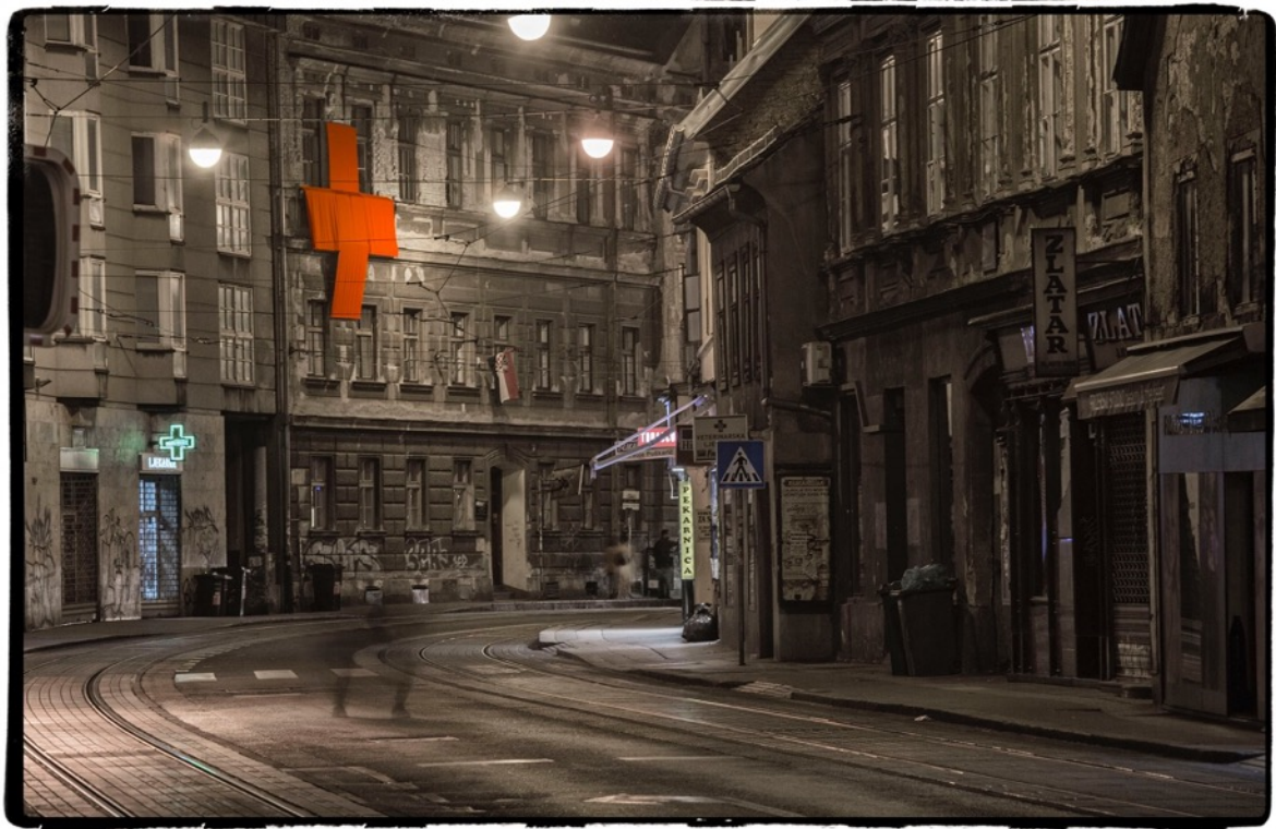
slika 25. Crveni križevi na oštećenim zgradama u potresu, Ilica 83, Zagreb, 2020. (foto Jasmin Krpan)
