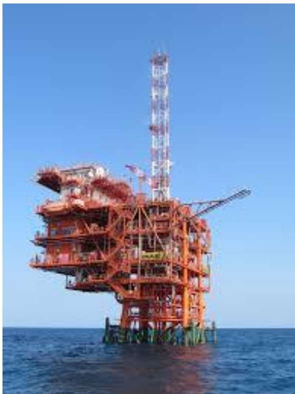
Slika 5. Plinska platforma u Sjevernom Jadranu
