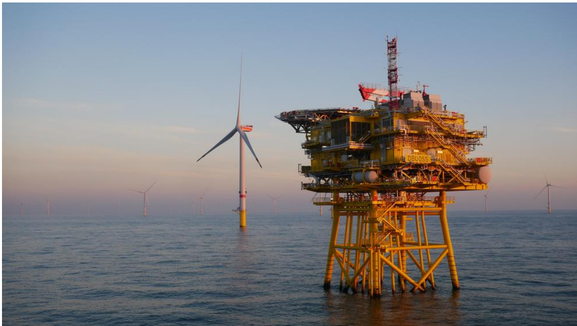
Slika 5: Platforma za eksploataciju nafte iz podzemlja
