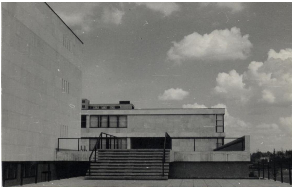
Slika 39. Zgrada Radničkog sveučilišta "Moše Pijade", Ulica grada Vukovara 68, zapadni prilaz na vanjsku terasu 276
