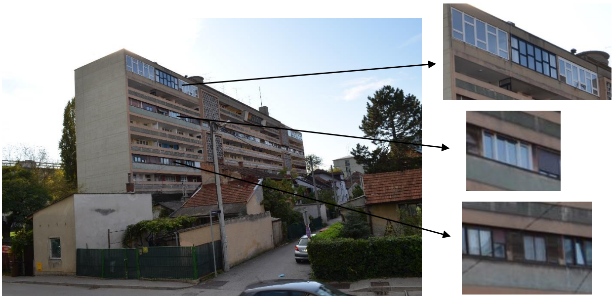
Slika 8. Začelje stambene zgrade Drage Galića u Ulici grada Vukovara 35-35a 226
