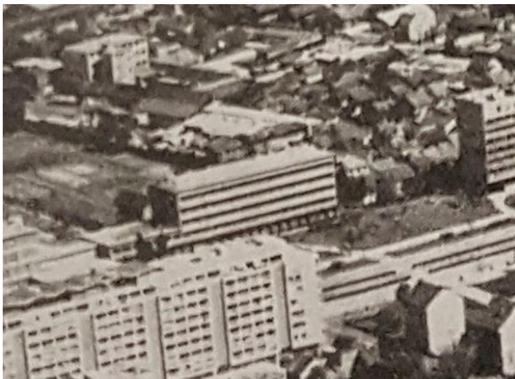
Slika 1. Sklop upravnih zgrada MUP-a RH 214
