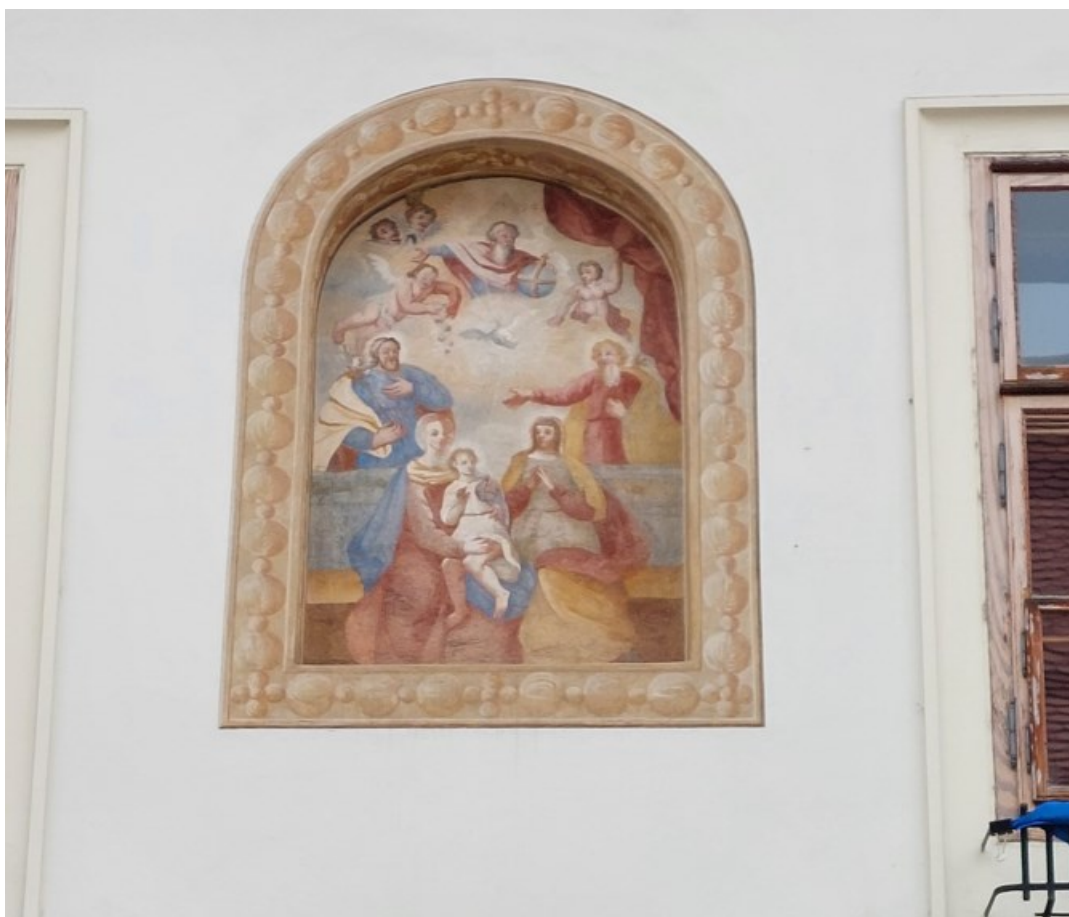
Slika 24. Oslík na Pročelju Ulice Tita Brezovačkog 1
