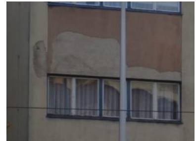
Slika 48. Pročelje uredske zgrade Nevena Šegvića, Ulica grada Vukovara 56-60 290
