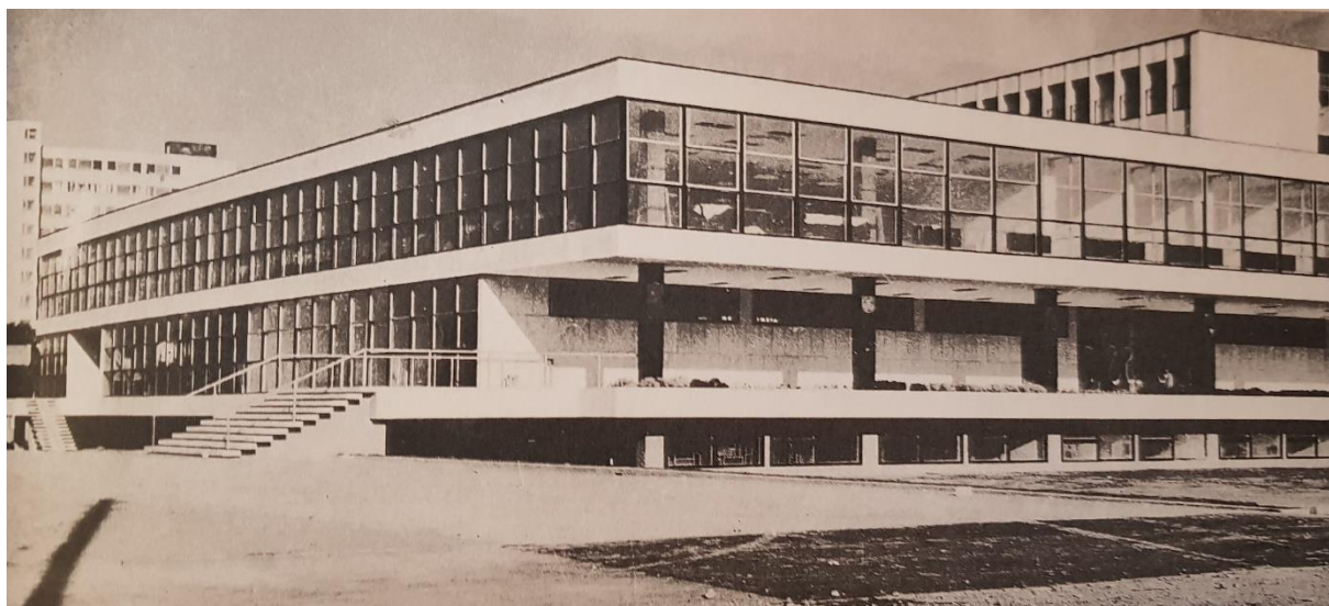
Slika 37. Zgrada Radničkog sveučilišta "Moše Pijade", Ulica grada Vukovara 68, pogled sa sjeverozapada 274
