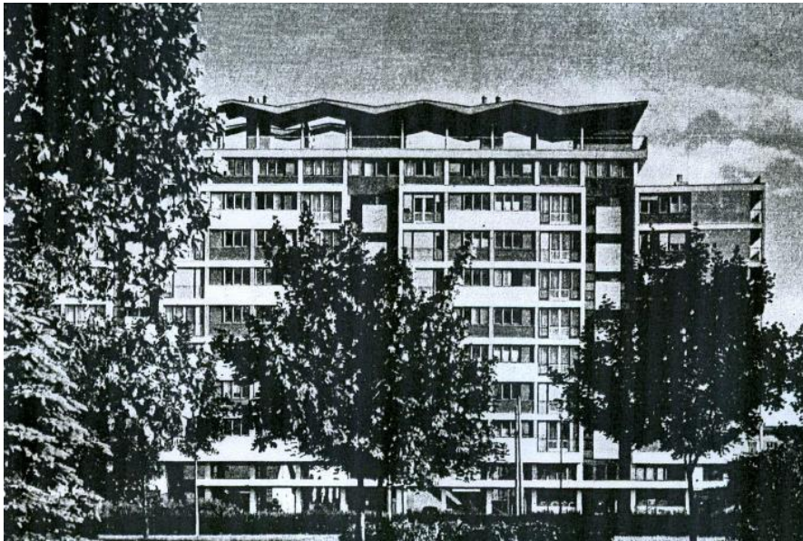
Slika 54. Pročelje višestambene osmerokatnice Vojne Mornarice Stanka Fabrisa, Ulica grada Vukovara 52a-e 300
