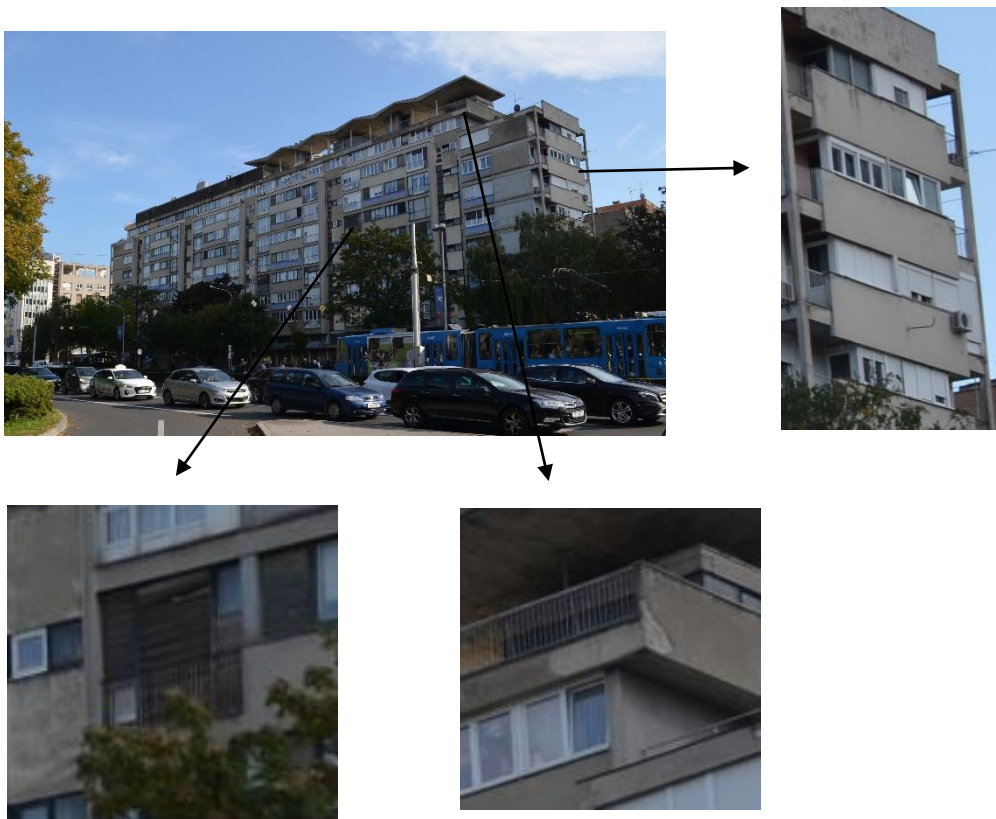
Slika 55. Pročelje višestambene osmerokatnice Vojne Mornarice Stanka Fabrisa, Ulica grada Vukovara 52a-e 301
