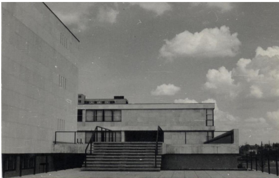
Slika 39. Zgrada Radničkog sveučilišta "Moše Pijade", Ulica grada Vukovara 68, zapadni prilaz na vanjsku terasu 276
