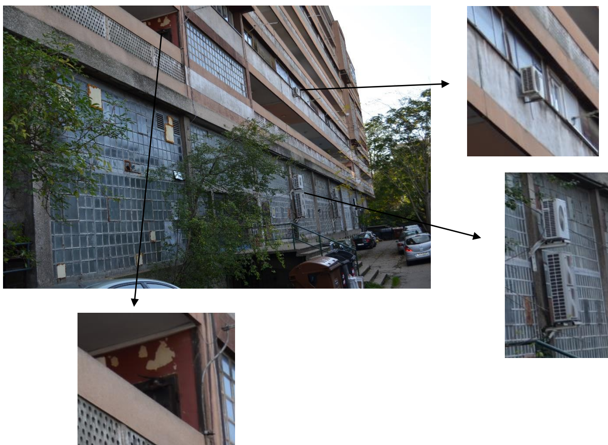
Slika 9. Detalj začelja stambene zgrade Drage Galića u Ulici grada Vukovara 35-35a 227
