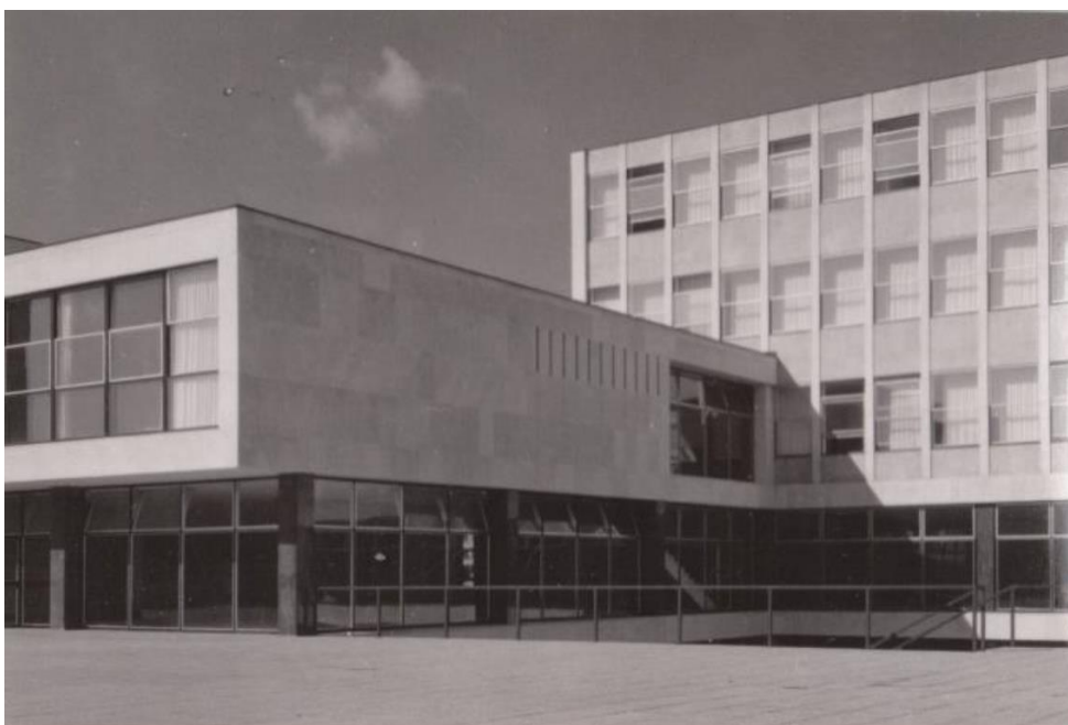
Slika 40. Zgrada Radničkog sveučilišta "Moše Pijade", Ulica grada Vukovara 68, pogled na vanjska pročelja Kluba i predvorja u prizemlju sa vanjske terase 277
