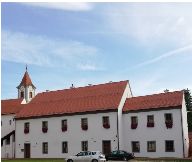
Slika 18: Faksimil barokne zgrade, pogled s istoka
