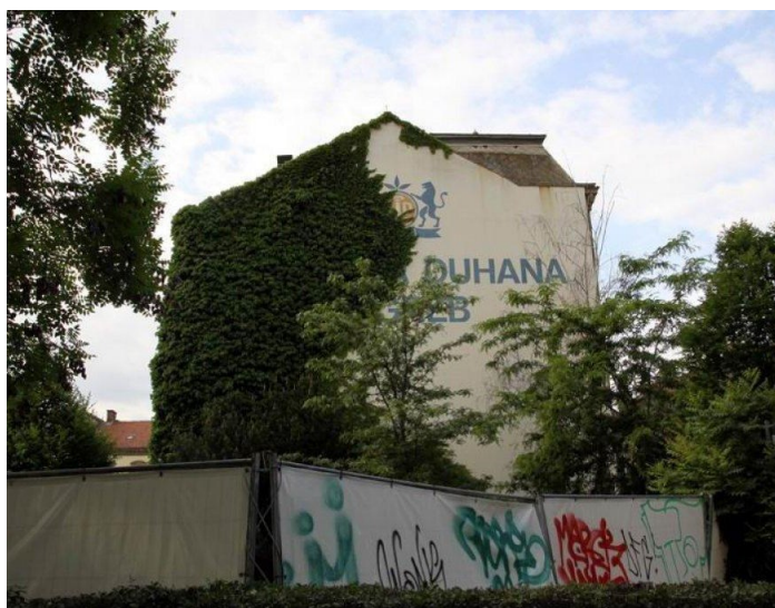
Slika 18.: Prikaz zabatnog zida na južnom pročelju istočnog kraka, 2015. godina
