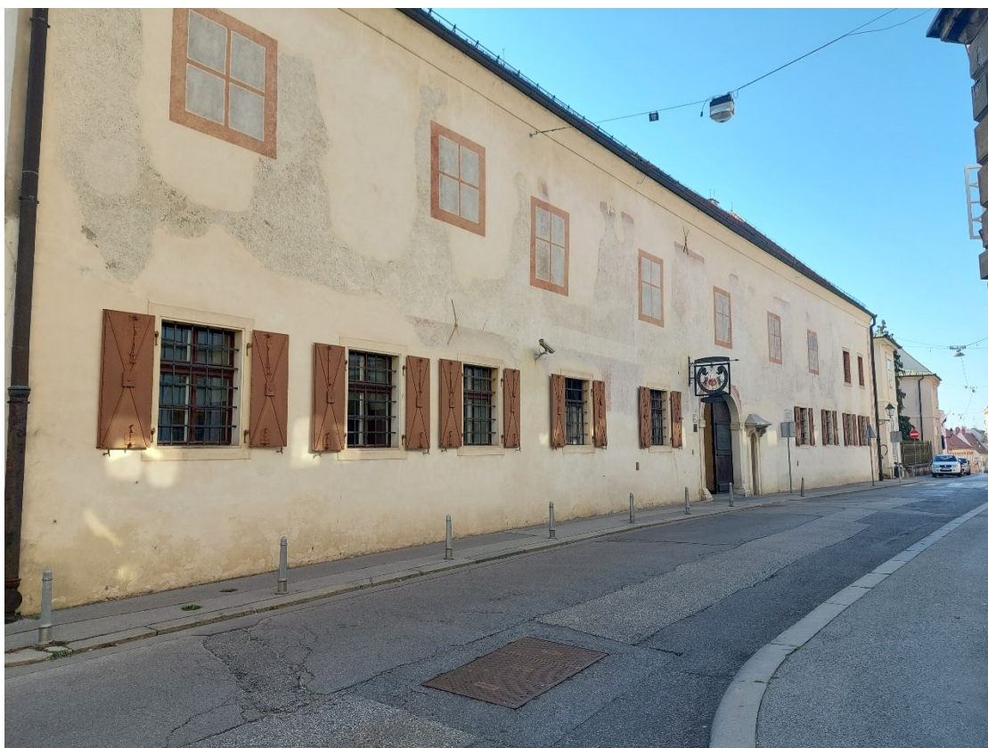
Slika 29. Zapadno pročelje Muzeja grada Zagreba
