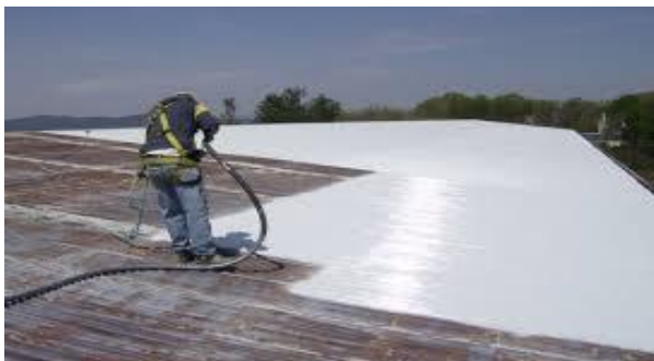
Slika 4. Primjer nanošenja organske prevlake prskanjem pomoću mlaznice [5]
