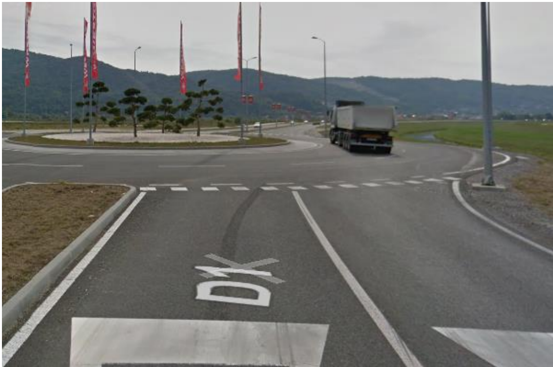
Slika 23. Pogled na „Raskrižje broj 3“ sa sjevernog privoza [7]
