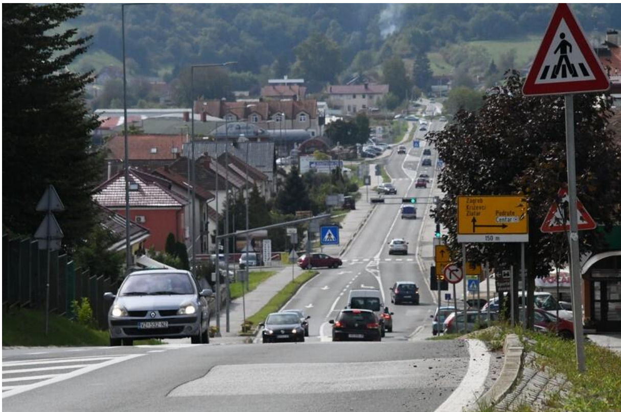
Slika 16: Zagrebačka ulica na državnoj cesti D3, Novi Marof
