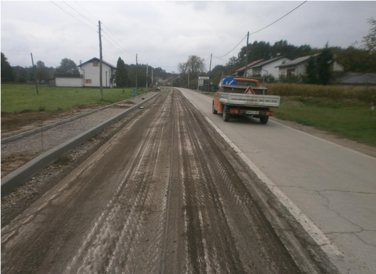
Slika 22. Skidanje habajućeg sloja asfalta
