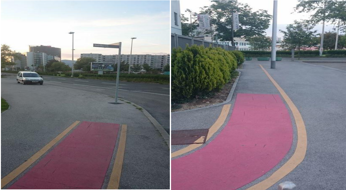
Slika 4. Prekid biciklističke trake (izvor: slikano 17.05.2016)
