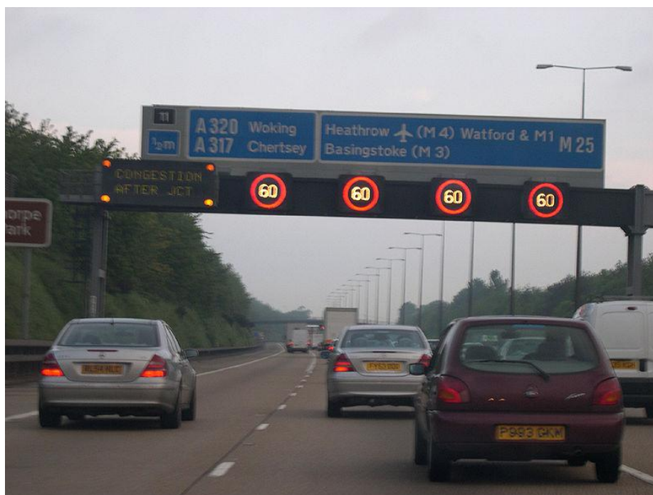
Slika 6. Prikaz VSL sustava implementiranog u okolici Londona
