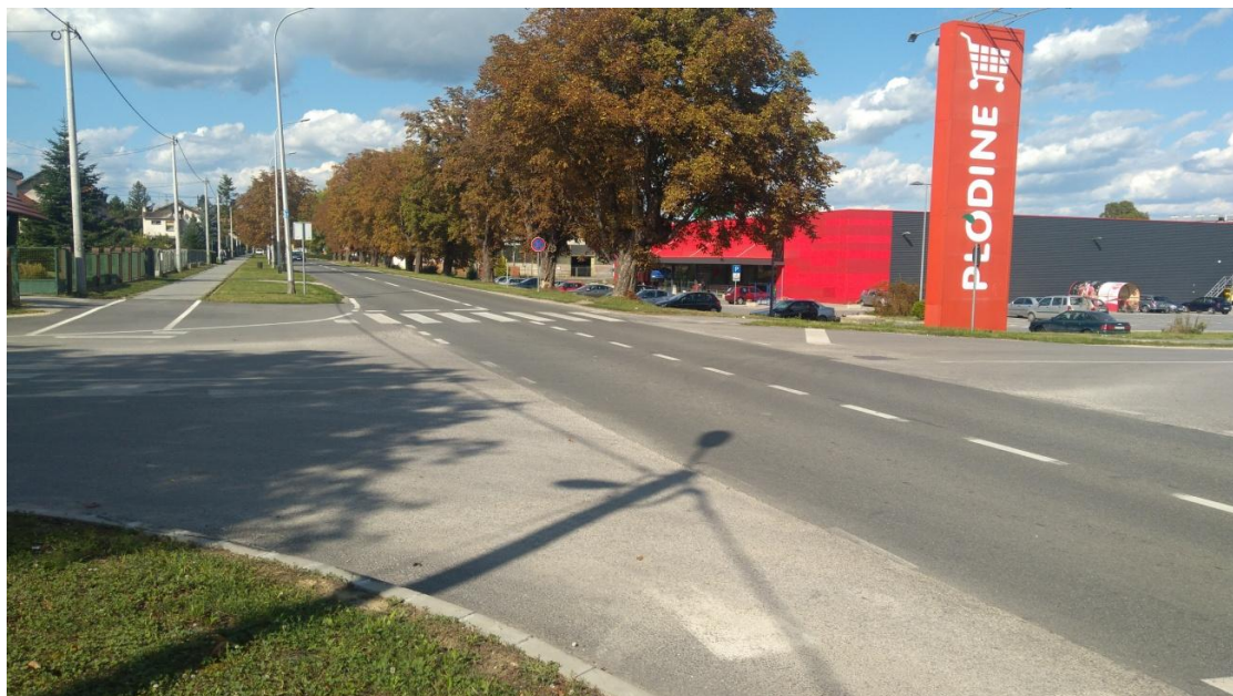
Slika 14. Pogled na raskrižje s južnog privoza
