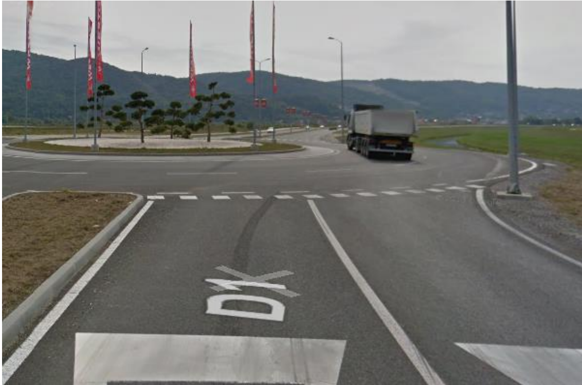
Slika 23. Pogled na „Raskrižje broj 3“ sa sjevernog privoza [7]
