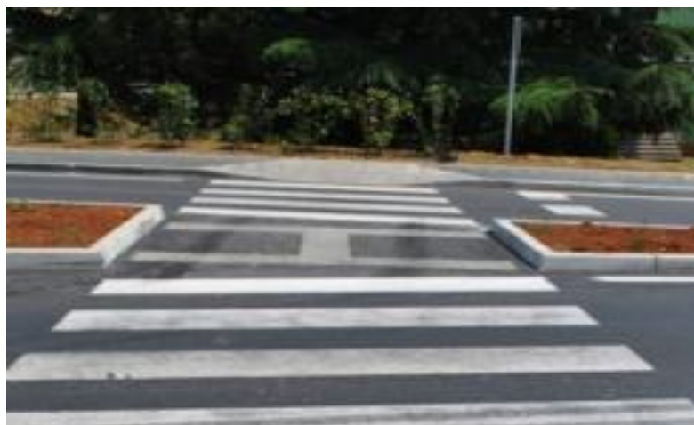
Slika 20. Pravilno izveden razdjelni otok
