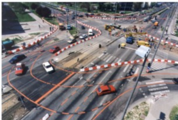
Slika 16: Oznake na kolniku izvedene trakama narančaste boje
