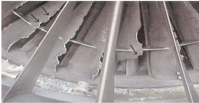
Slika 7. Oštećenje lopatice zrakoplova, [10]
