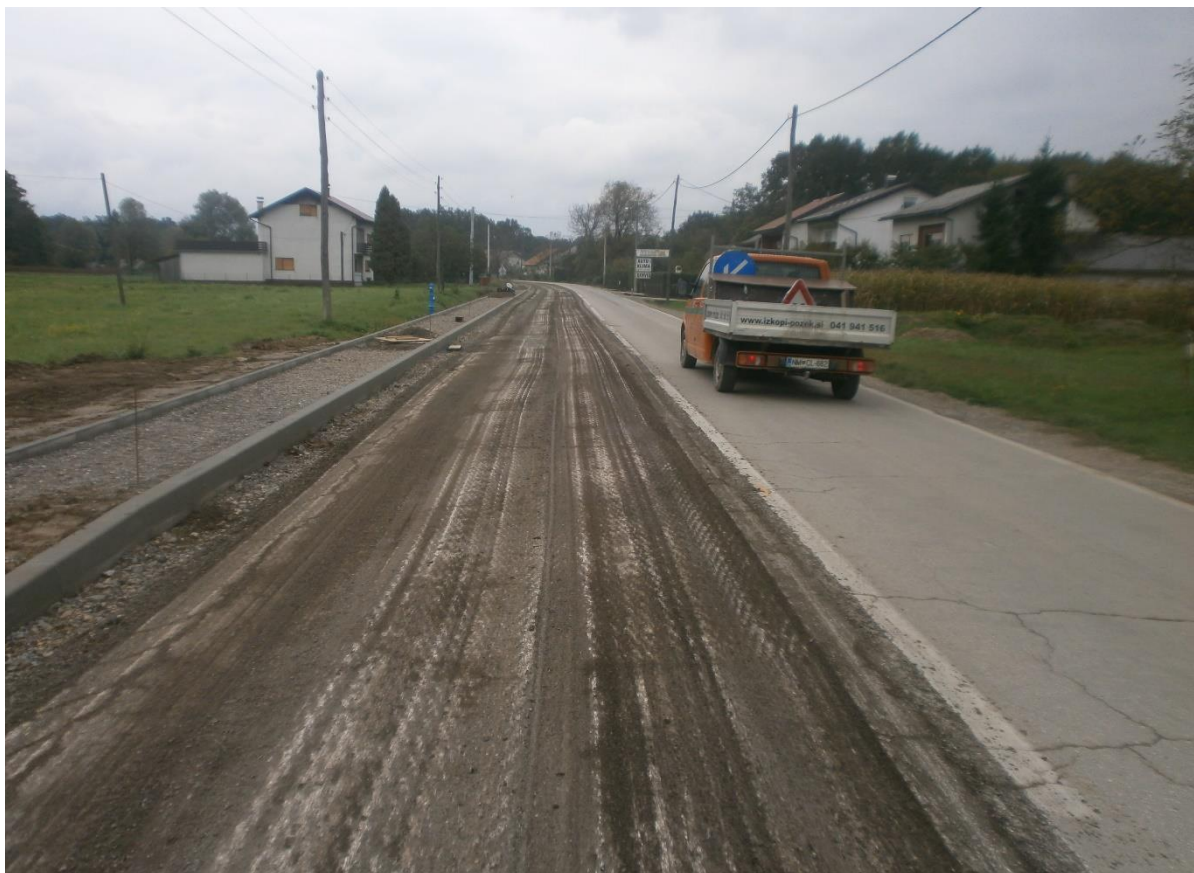
Slika 22. Skidanje habajućeg sloja asfalta
