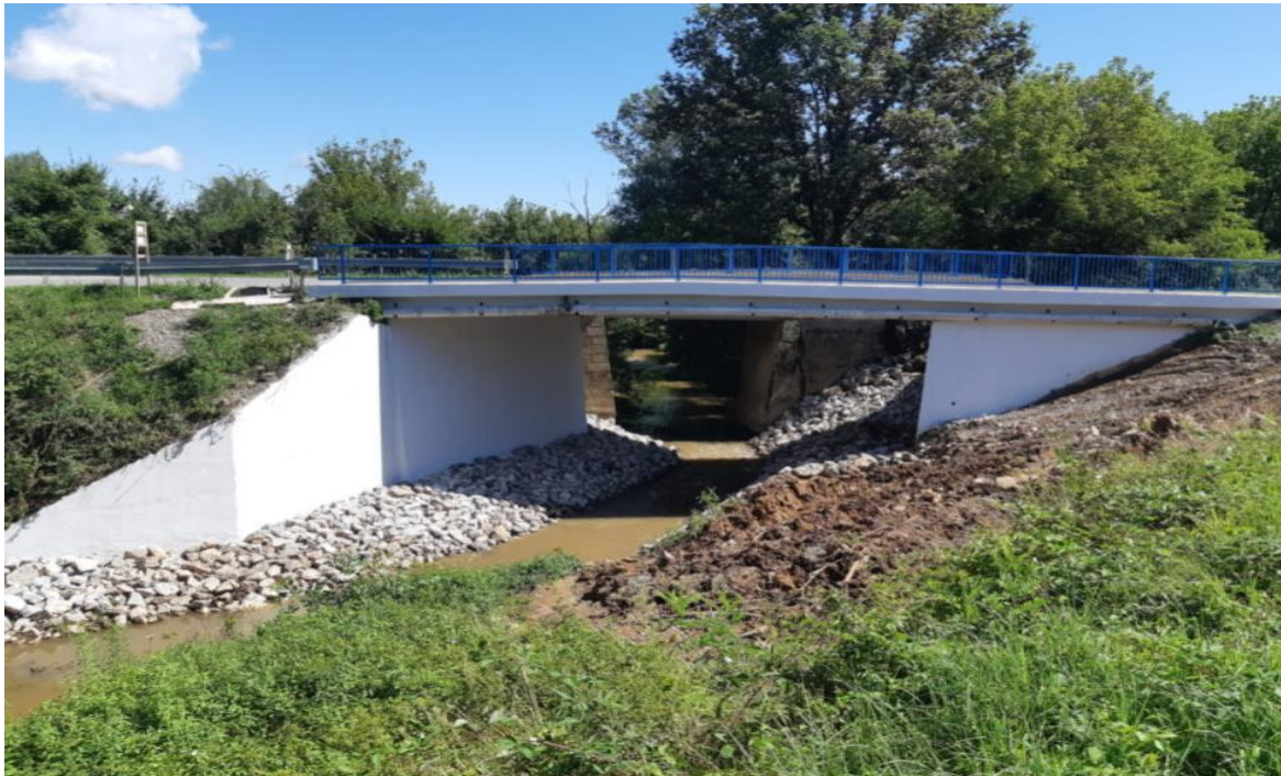
Slika 12. Sanacije mosta Kremešnica
