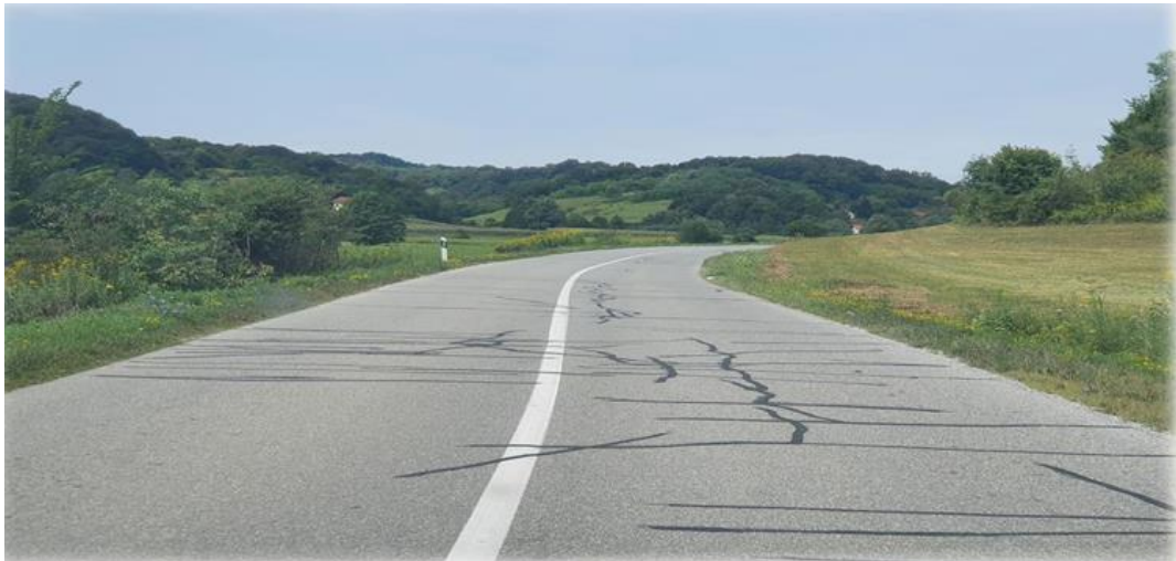
Slika 16: Sanacija pukotina na županijskoj cesti ŽC2248 (Velika Horvatska)
