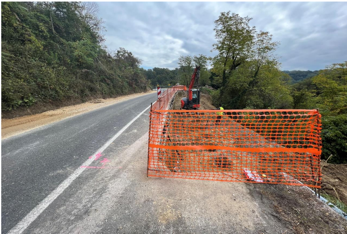
Slika 40: Radovi iskopa i ugradnja armaturnih pilota
