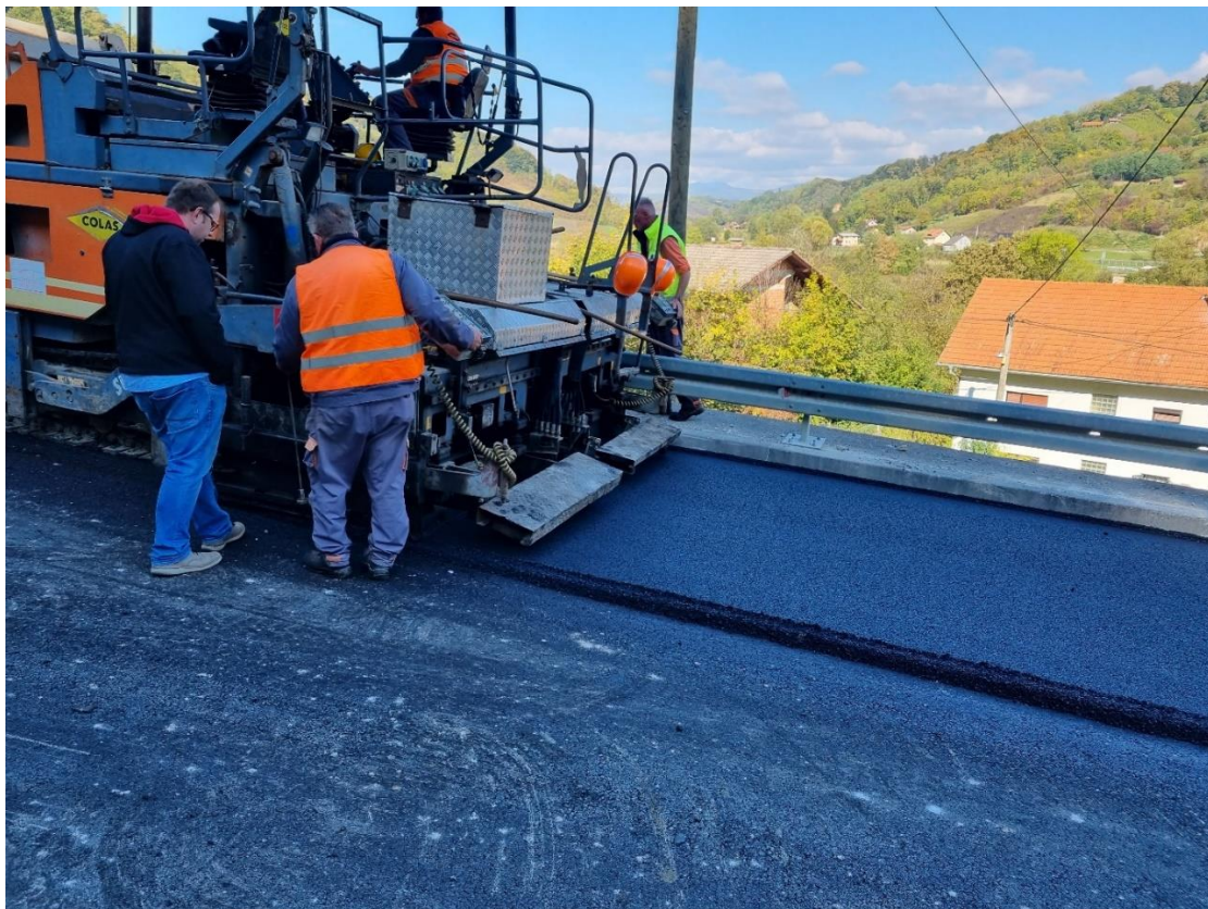
Slika 14: Strojna ugradnja asfalta
