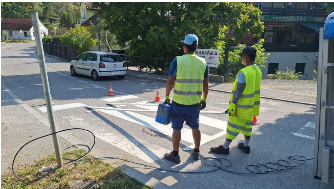
Slika 18: Bojanje pješačkog prijelaza
