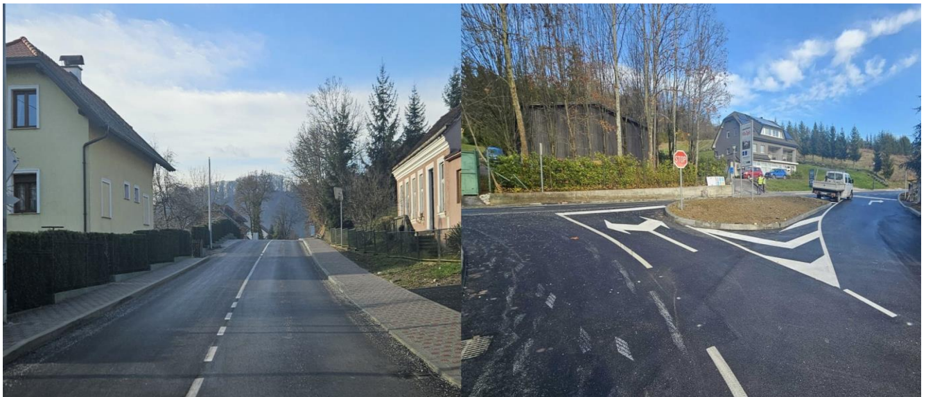
Slika 34: Mihanovičeva ulica nakon rekonstrukcije
