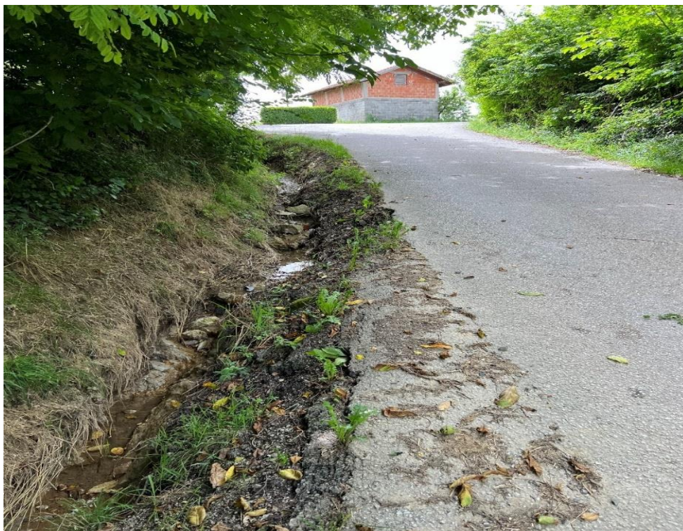
Slika 17: Onečišćeni odvodni jarak
