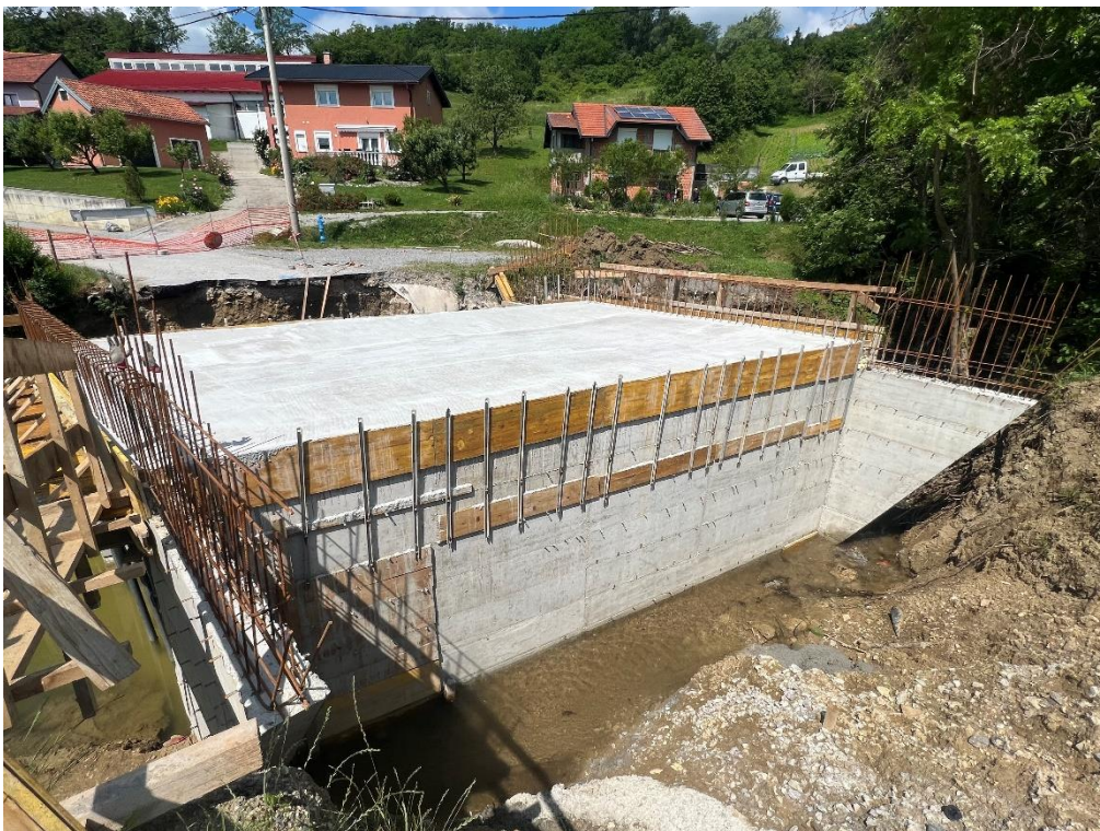
Slika 37: Završena betonska konstrukcija propusta
