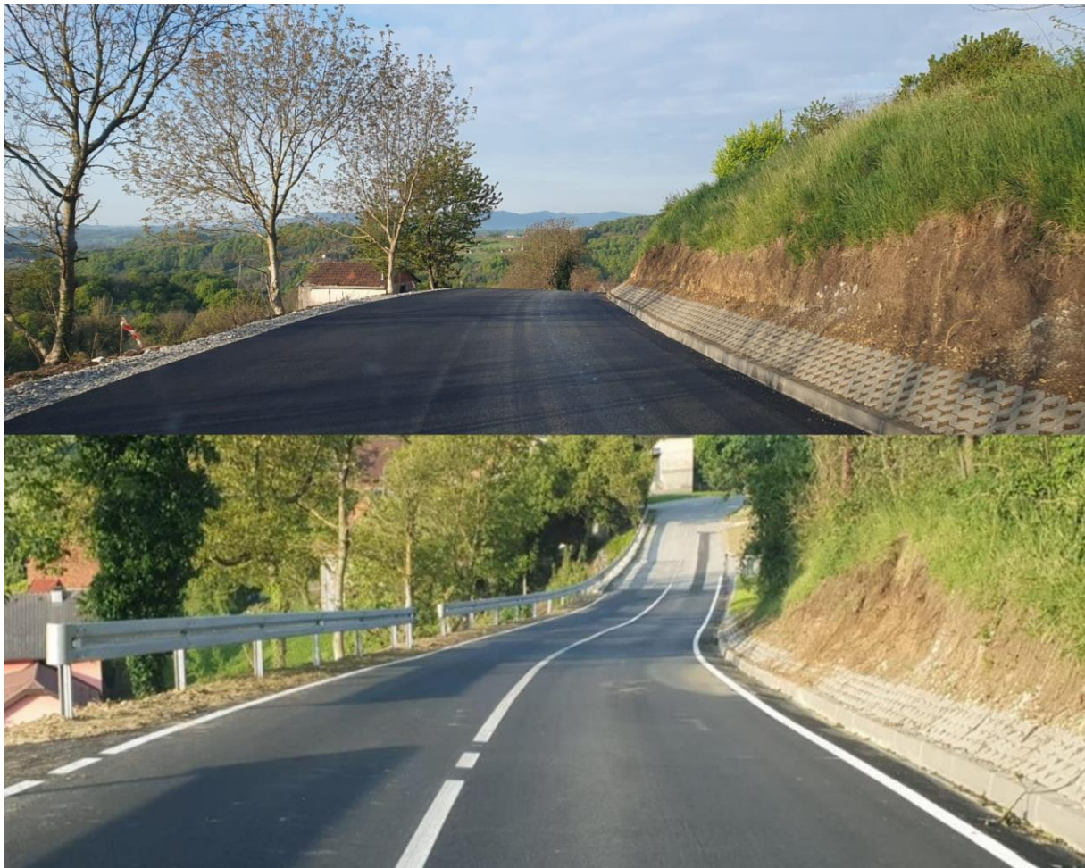
Slika 32: Stanje nakon izvršenih radova sanacije
