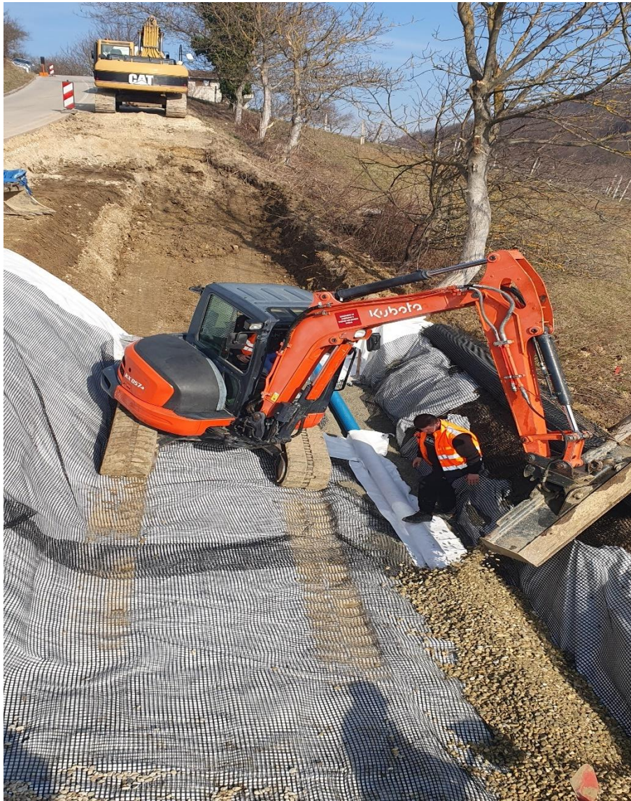
Slika 29: Postava geotekstila
