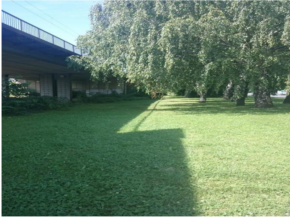
Slika 17. Postojeće stanje Ulice kneza Branimira (izvor: slikano 10.07.2015.)
